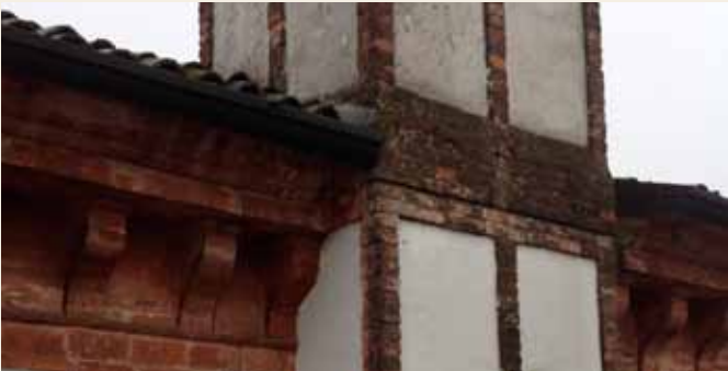
Particolare del fregio perimetrale sottogronda in cotto
